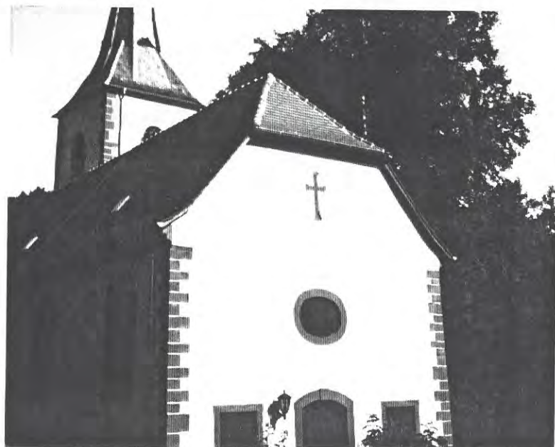
FREIGELEGTES KREUZ AN DER WESTSEITE DES KIRCHENSCHIFFS
